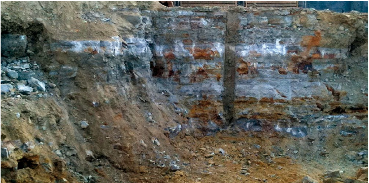
Abb. 2: Bänke von insgesamt 3 m anstehendem, sehr hartem, quarzitischem Sandstein, Baugrube Geisbergstr. 19 (2011) (Baugrubenhöhe ca. 4,5 m) (vgl. Abb. 1).
