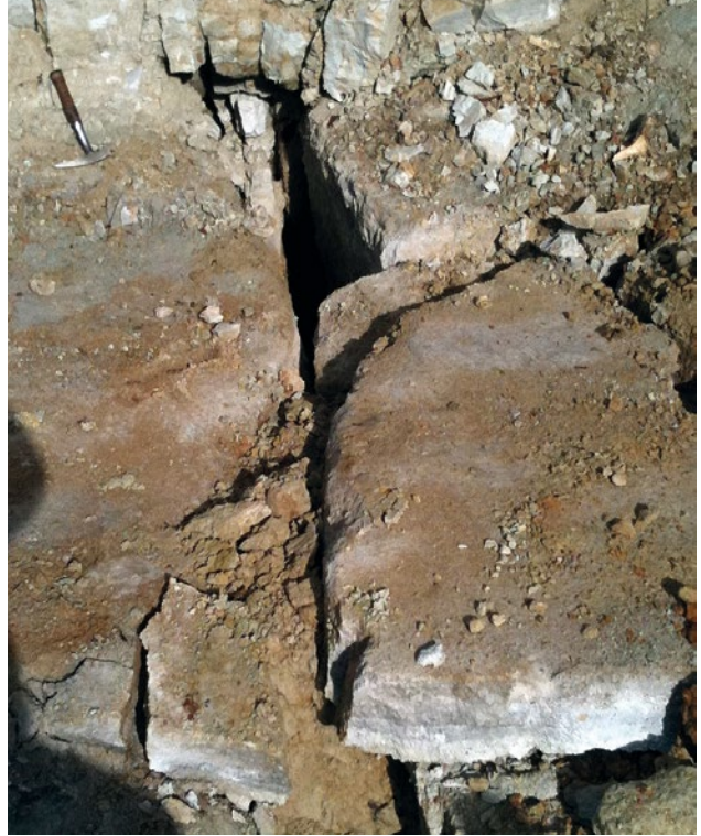
Abb. 4: Offene Spalten im Sandstein, vermutete Aufstiegswege der silifizierenden Thermalwässer (Baugrube Geisbergstr. 19, 2011).
