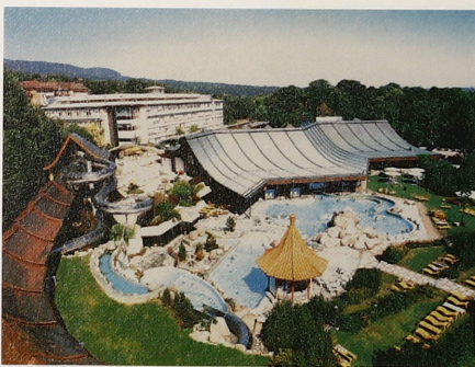
Abb. 13. An vielen Orten werden Heil- und Thermalquellen zur Errichtung von Bädern genutzt, hier die Kurhessentherme in Kassel.
