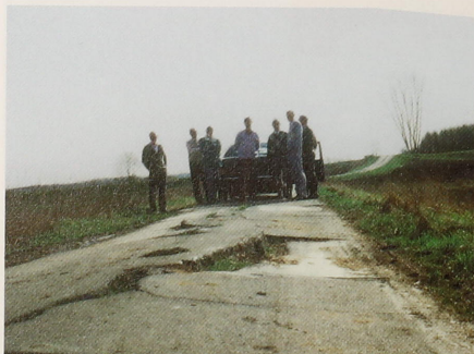
Abb. 10. Im dicht besiedelten und intensiv genutztem Hessischen Ried führte die Grundwasserentnahme lokal zu Bodensetzungen und Schäden, etwa an Straßen.
