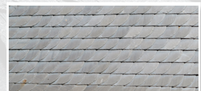
Dachschieferplatten an einer Hauswand, Stadt Frankenberg
