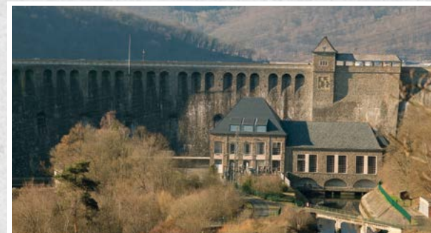
Abb. 5: Die Edersee-Talsperre ist aus Kulm-Grauwaacken aus nahegelegenen Steinbrüchen erbaut (Natursteinname: Edersee-Grauwaacke)
