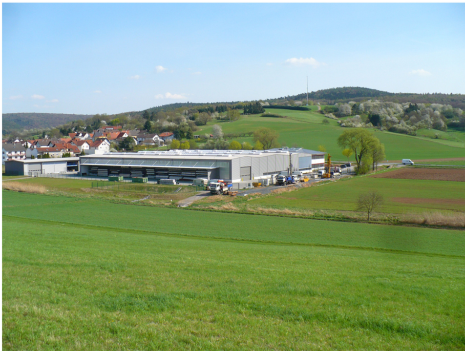
Abbildung 2.1 Die neuen Produktionshallen des Unternehmens Frenger Systemen BV GmbH in Heubach, die mit Erdwärme geheizt bzw. gekühlt werden (HLUG online).
