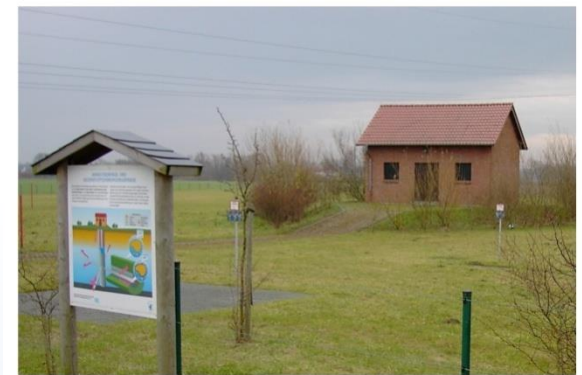
Wasserwerk Boker Heide, Paderborn
