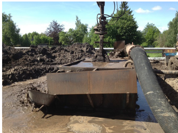
Gesicherte Box für NaOH zur pH Wert Einstellung > 10
