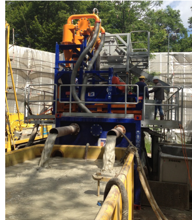
Bentonit-Polymerspülung für Tiefbrunnen in Ludwigshafen Mai 2014
