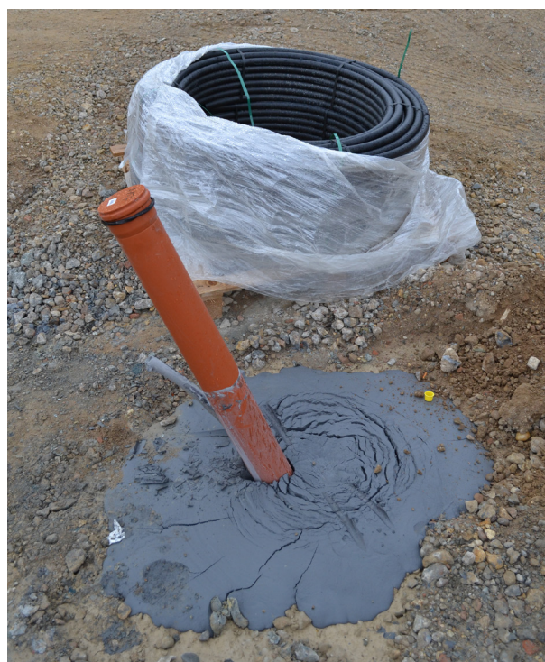
Abb. 9: Verpresste Sondenbohrung.
