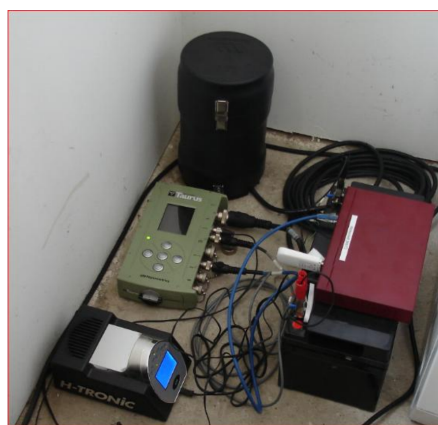
Aufbau einer Erdbebenstation im Projekt SiMoN+ (in rot der Router über den die Daten übertragen werden).
