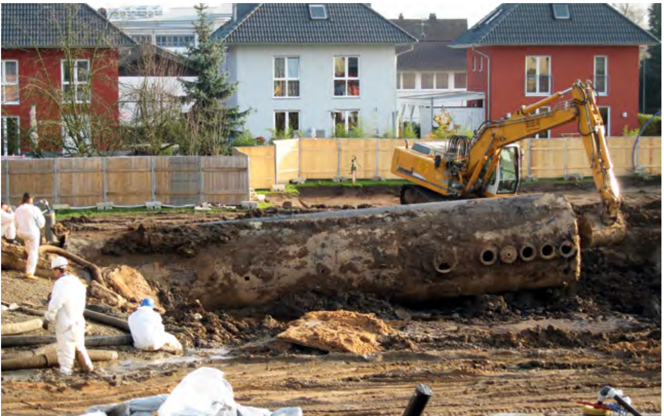
Abb. 2: Tankaushebung und Bodensanierung © HIM-ASG
