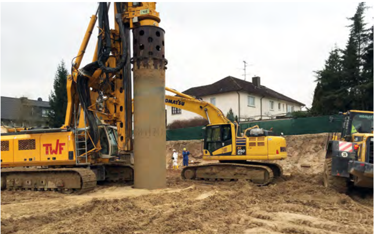
Abb. 3: Bodensanierung mittels Großlochbohrungen © HIM-ASG
