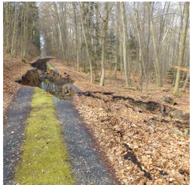
Abb. 9: Mit zunehmenden Extremwetterereignissen aufgrund des Klimawandels nehmen auch Geogefahren wie Rutschungen zu, hier am Bärstedter Wald
