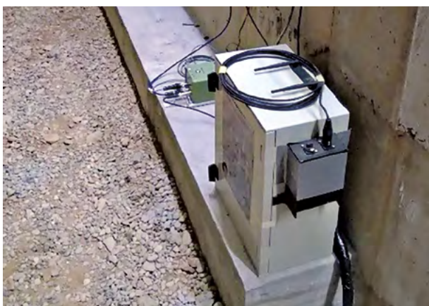
Abb. 7 Starkbebenstation in Darmstadt
