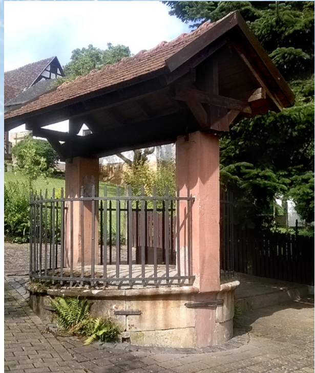
Abb. 2: Schachtbrunnen Wippenbach Nr. 486039.
