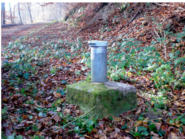
Abb. 1: Grundwassermessstelle Wörsdorf Nr. 506029.
