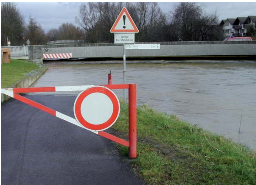
Abb. 1: Hochwasser an der Nidda.
