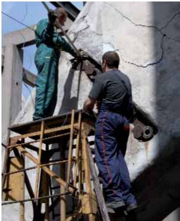
Abb. 3: Messbühne mit Mitarbeiter während der Staubprobennahme.
