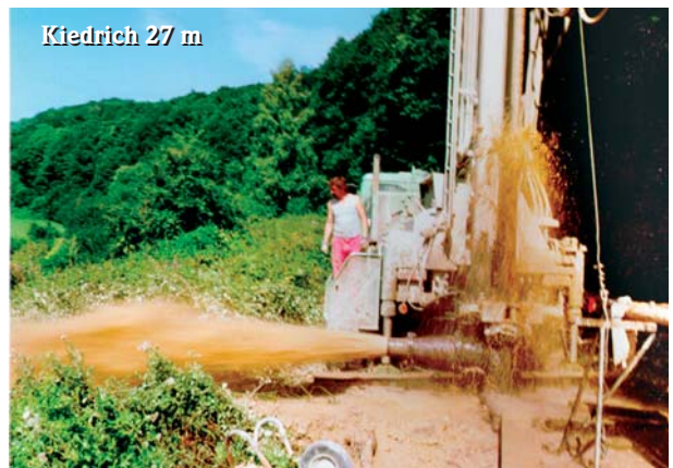
Abb. 3: Bohrung für Grundwassermessstellen: Beispiele für Grundwasseraufschlüsse, an denen Quellschüttung und Wasserstände gemessen werden.
