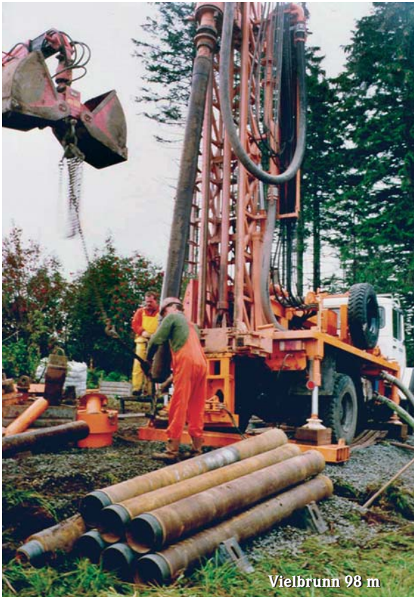
Abb. 3: Bohrung für Grundwassermessstellen: Beispiele für Grundwasseraufschlüsse, an denen Quellschüttung und Wasserstände gemessen werden.
