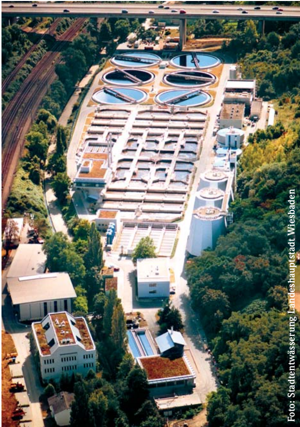
Abb. 12: Hauptkläranlage Wiesbaden im Juni 2005.
