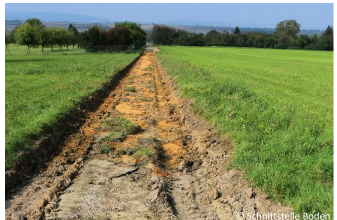
Entsiegelter Wirtschaftsweg vor Herstellung einer durchwurzelbaren Bodenschicht
