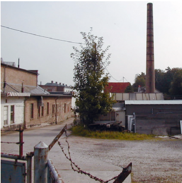
Abb. 7. Aufgegebenes Fabrikgelände in einer Bachau. Ursprünglich Nutzung von Wasserkraft, später Umstellung auf Dampfmaschine (Schornstein); Sekundärnutzung der Gebäude mit diversen Gewerben. (Quelle: Bildarchiv Altflächen Planungsverband)
