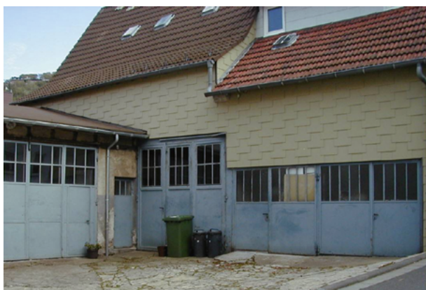
Abb. 8: Über Generationen in Familienbesitz geführte Handwerksbetriebe – hier eine ehemalige Schlosserei – wurden mangels Nachfolger aufgegeben und stehen heute leer. (Quelle: Bildarchiv Altflächen Planungsverband)
