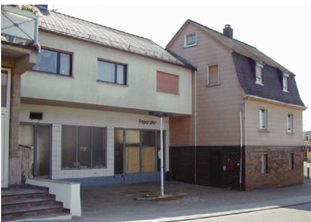
Abb. 5. Zustand Ende der 1990er Jahre (Quelle: Bildarchiv Altflächen, Planungsverband)
