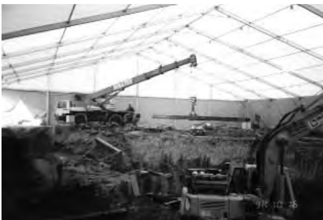
Abb. 5: Baugrubenverbau, Einbau der Gurtungen und Steifen mit Autokran.
