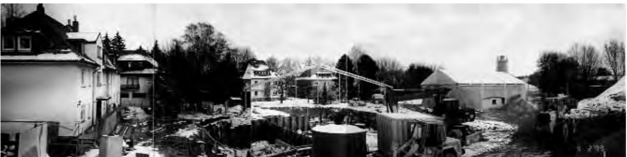
Abb. 9: Aushubzelt im Abbau, Spundwände noch nicht gezogen.
