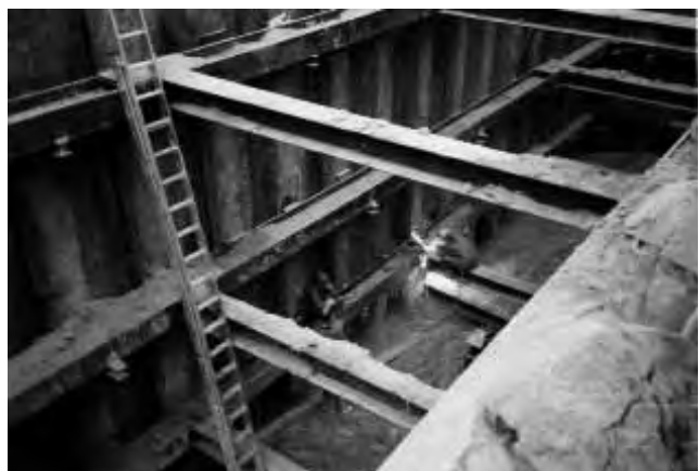
Abb. 6: Baugrubenverbau – Schweißarbeiten an der Aussteifung der 3. Gurtung.
