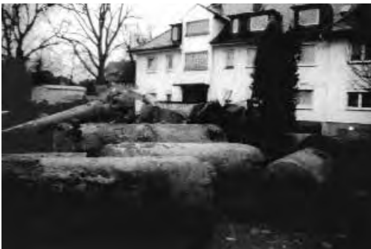
Abb. 1: Geborgene Erdtanks (nach Abriss des eingesch. Betriebsgebäudes).
