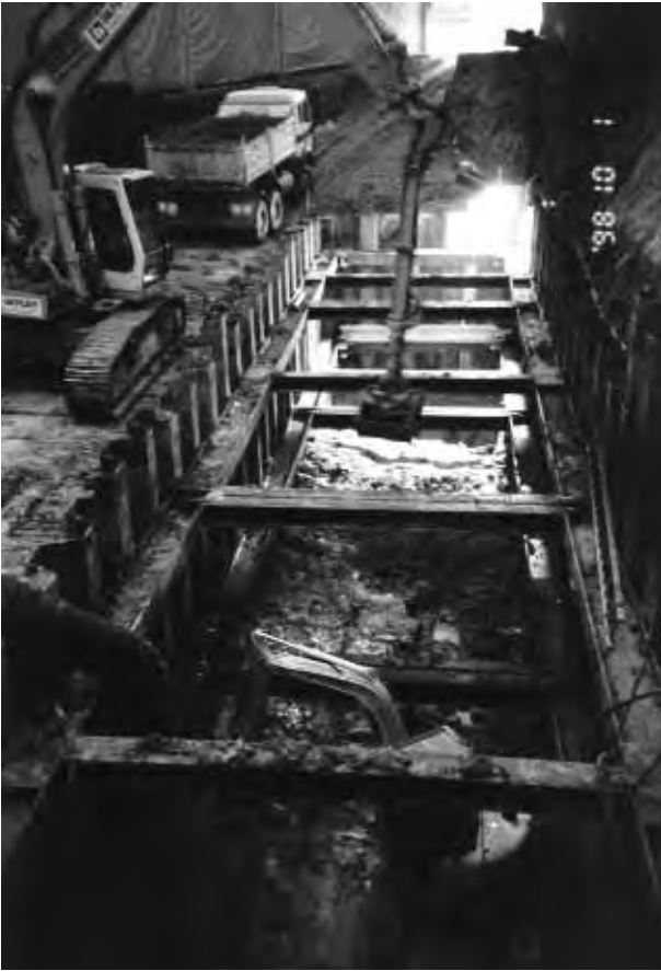
Abb. 7: Aushub – unten und oben Bagger im Einsatz.
