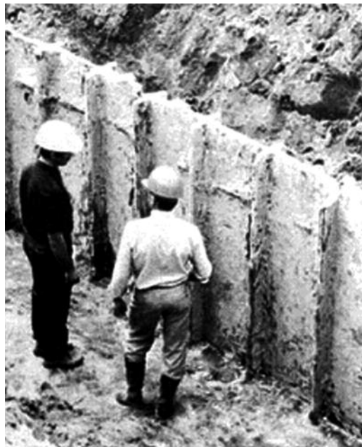
Abb. 5: Frei gelegte Schmalwand.
