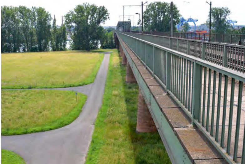
Abb. 10: Eisenbahnstahlbrücke im Bereich oberflächennaher Wassergewinnung.
