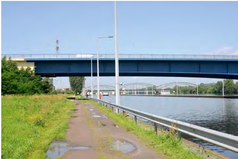
Abb. 9: Stahlbrücke (Autobahn) im Vordergrund, Hochspannungsmast und Eisenbahnstahlbrücke im Hintergrund.
