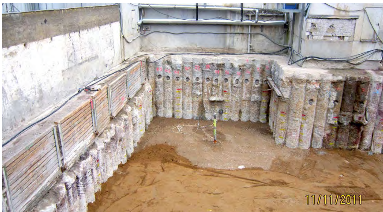
Abb. 5: Blick auf den Bohrpfahlwandverbau.
