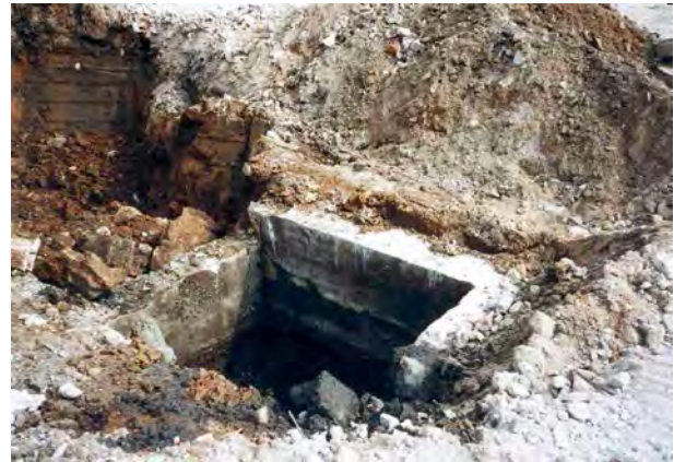
Abb. 1: Aushub des Absetzbeckens nach der Entleerung.
