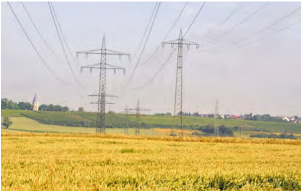
Abb. 6: 110 kV Trasse im Rhein-Main-Gebiet.
