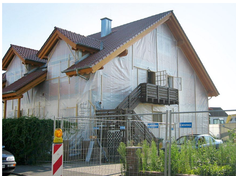
Abb. 4: Folienabhangung eines Wohnhauses.
