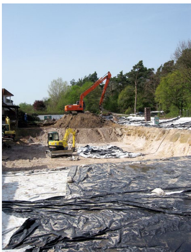
Abb. 3: Bodenaustausch im 5. Sanierungsabschnitt.
