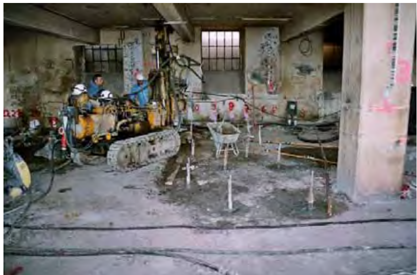
Abb. 2: Kleinbohrgerät bei Injektionsbohrungen im Keller.
