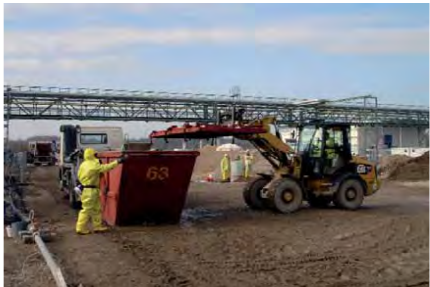
Abb. 10: Luftdichter Container und Arbeitsschutzmaßnahmen
