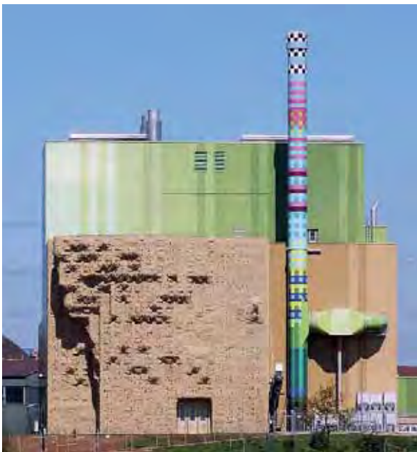
Abb. 1: Das Biomassekraftwerk verfügt über eine elektrische Leistung von bis zu 15 Megawatt. Dort werden bis zu 120 000 Tonnen Altholz jährlich energetisch verwertet).
