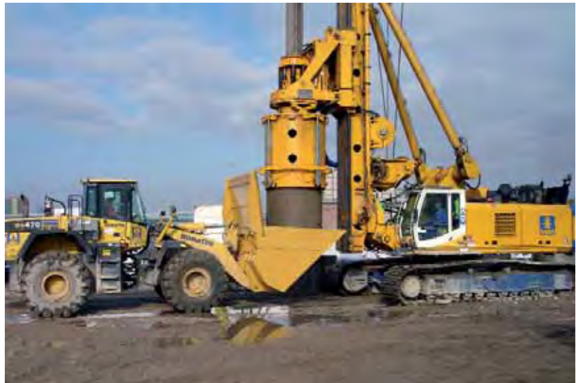
Abb. 9: Drehbohrgerät BAUER BG 40 im Einsatz
