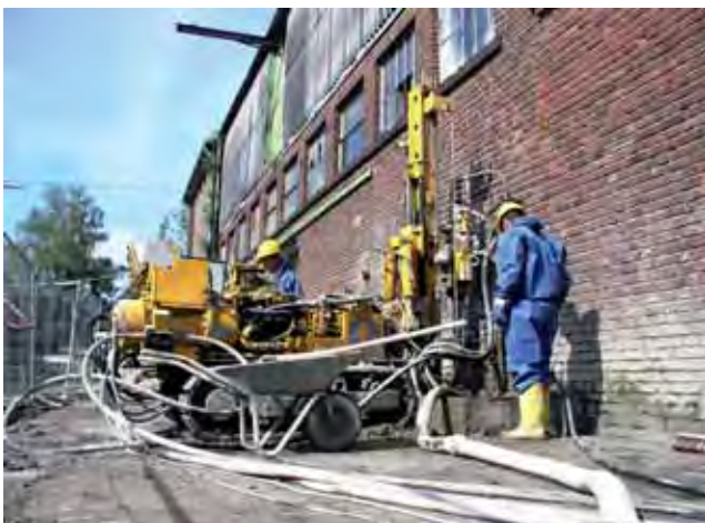
Abb. 4a / 4b: Kleinbohrgerät bei Außen- / Innenarbeiten
