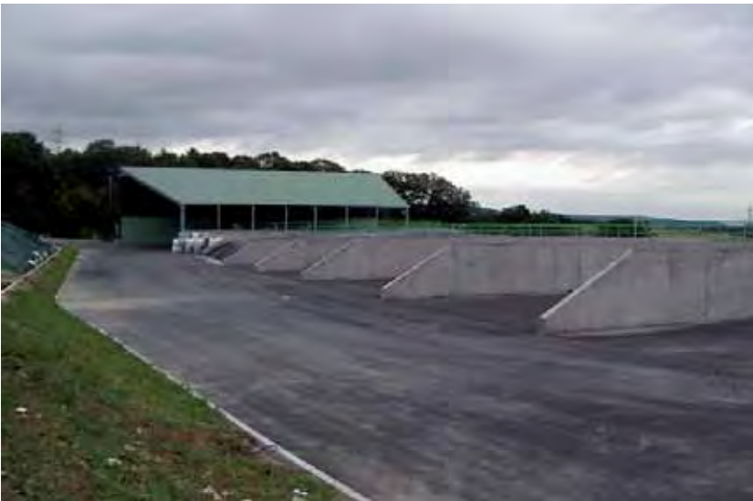
Abb. 4: Agrogasanlage im Deponiepark Brandholz.
