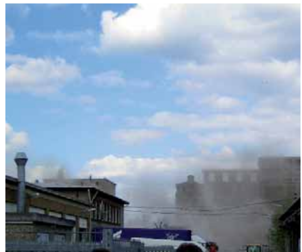
Abb. 5 und 6: Baufälliger Säureturn vor und nach der Sprengung.
