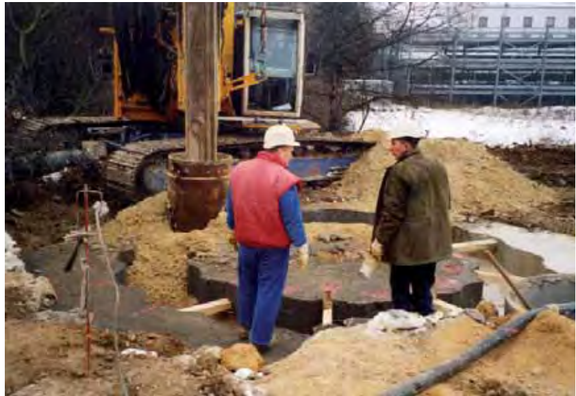
Abb. 6: Überschnittene Bohrpfehlwand als Gate.
