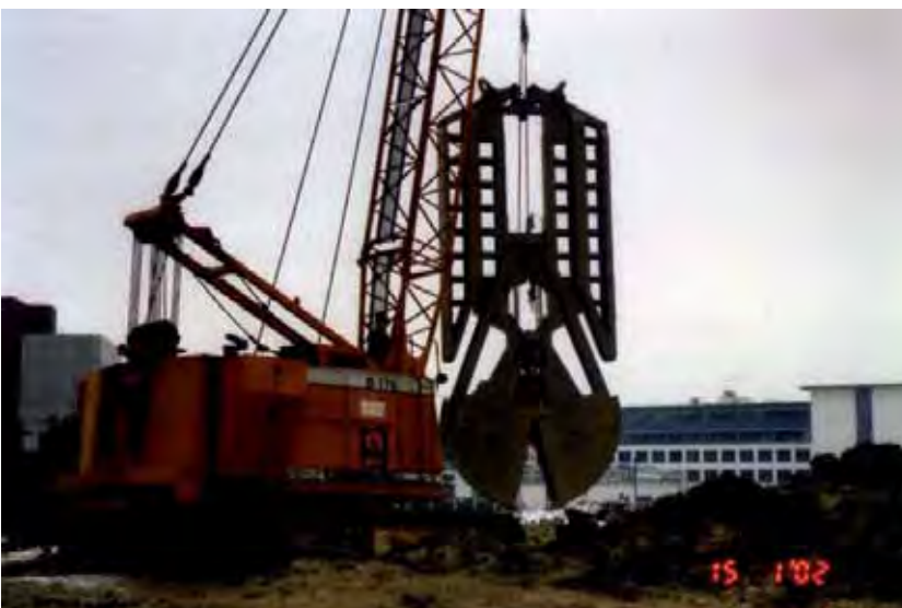
Abb. 5: Schlitzdichtwand als Funnel.
