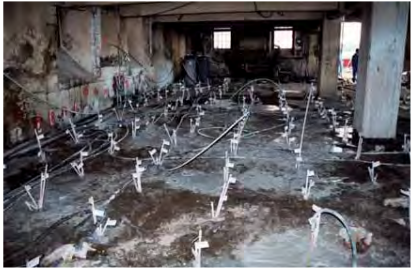
Abb. 1: Injektionspunkte im Keller.
