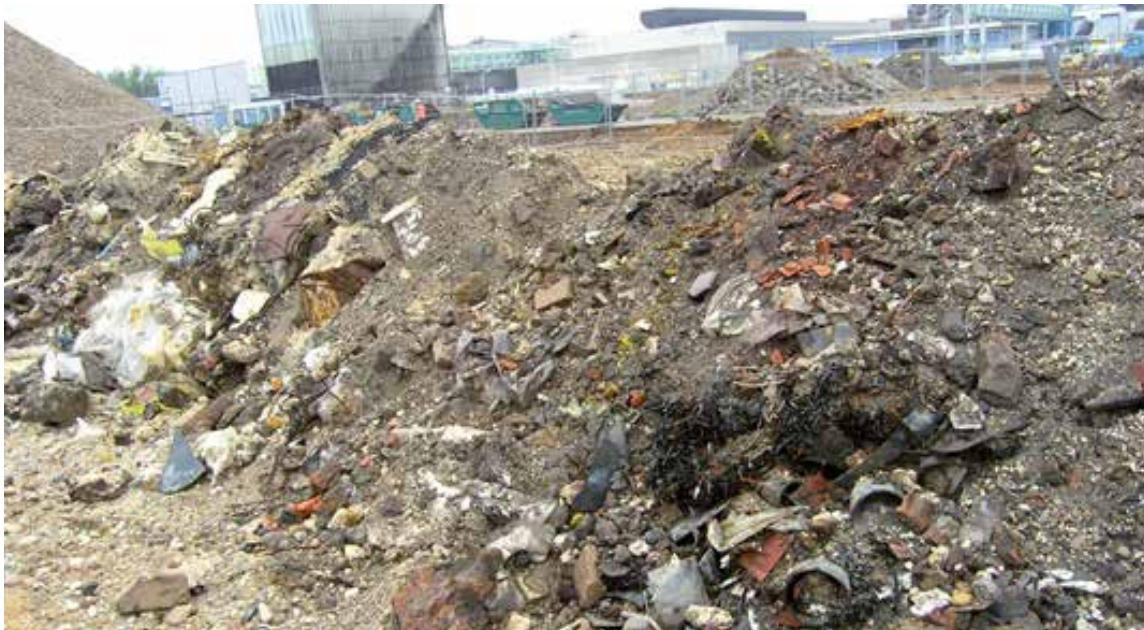
Abb.9: Bodenaushub im Südteil des Industriepark Höchst (2008)
