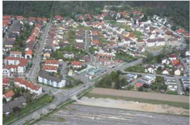
Abb. 4: Luftbild (Sanierung des 4. Sanierungsabschnittes).
