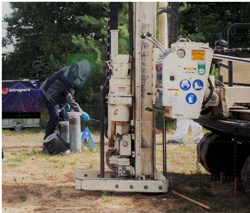
Abb. 2: Direct-Push Injektion von rund 18 m 3 Intraplex B® Aktivkohle-Suspension in den belasteten Aquifer 30 m u. GOK.
