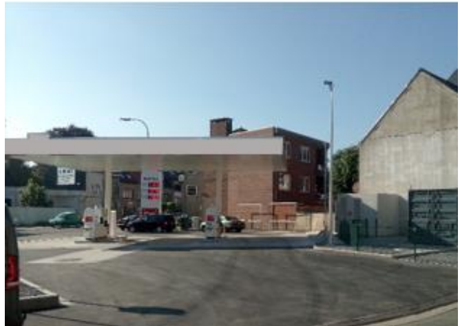
Abb. 3: Sanierung während aktivem Tankstellenbetrieb; rechts ist der Container (Sanierungstechnik) zu sehen
