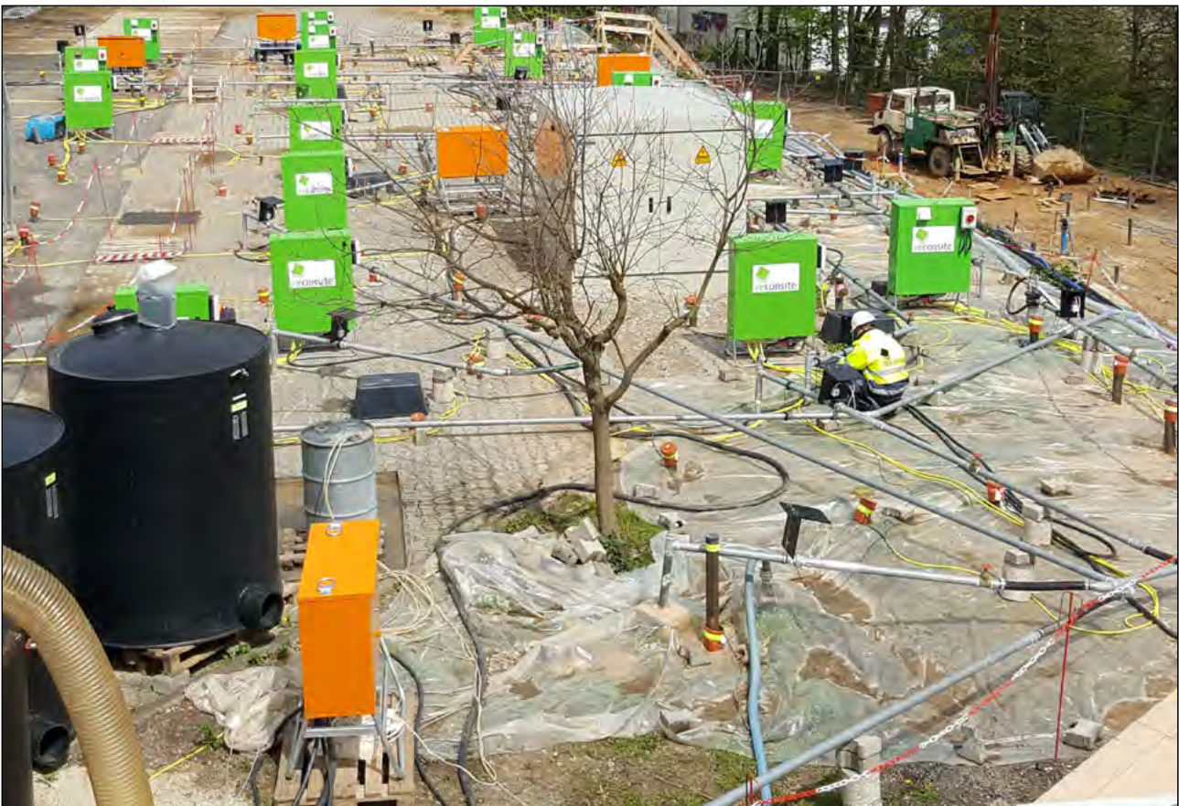
Abb. 8a: Blick auf eine thermische in-situ Sanierung mit dem THERIS®-Verfahren (feste Wärmequellen)
