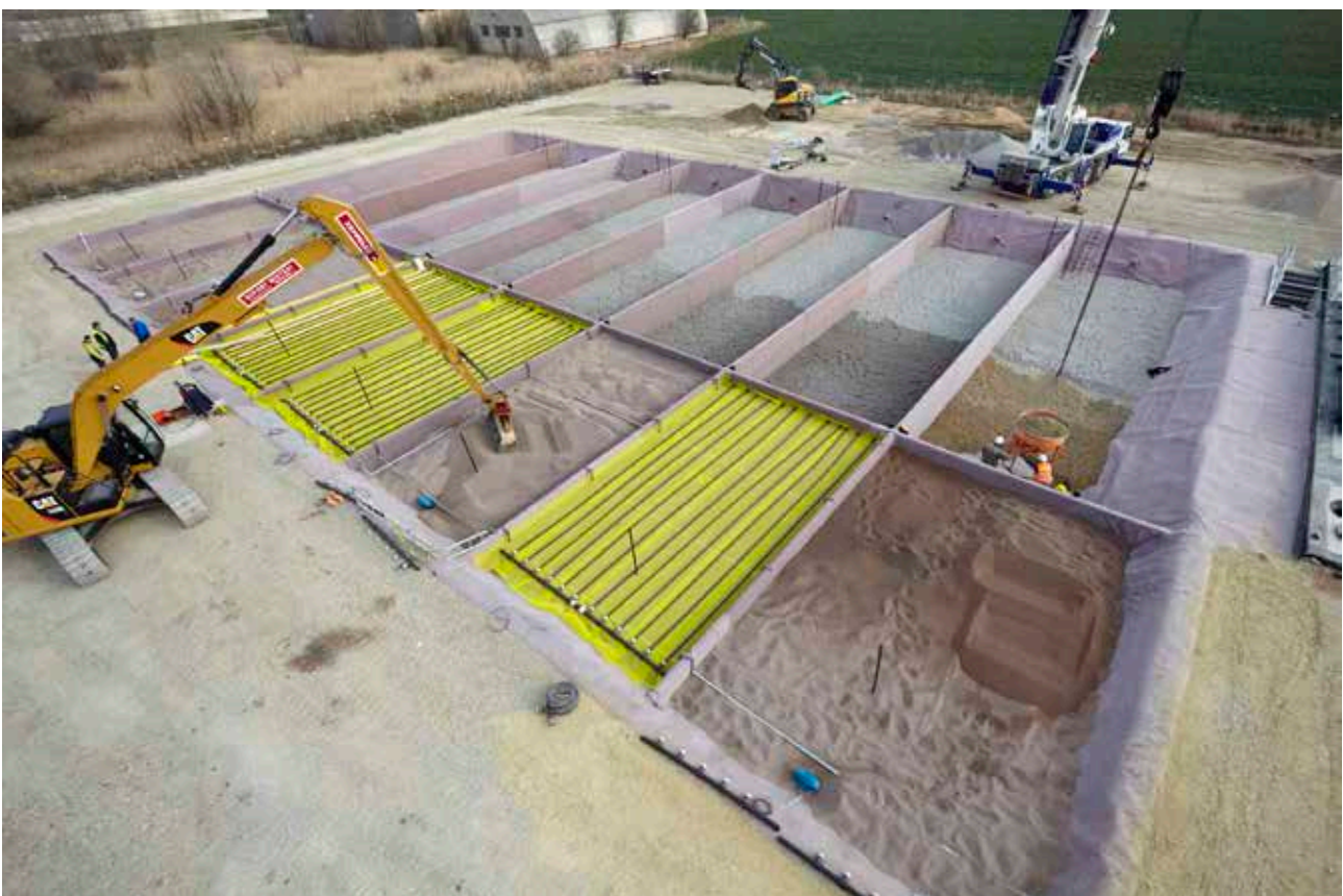
Abb. 3: Herstellung der großtechnischen Grundwasserreinigungsanlage Leuna I
